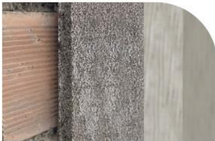
اجرای لایه رویه
