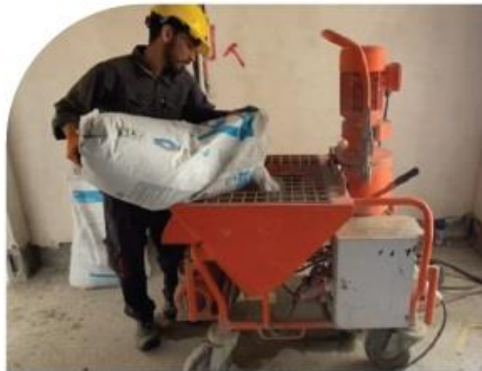
مخلوط نمودن ملات خشک در میکسر و پمپ نمودن ملات خشک
