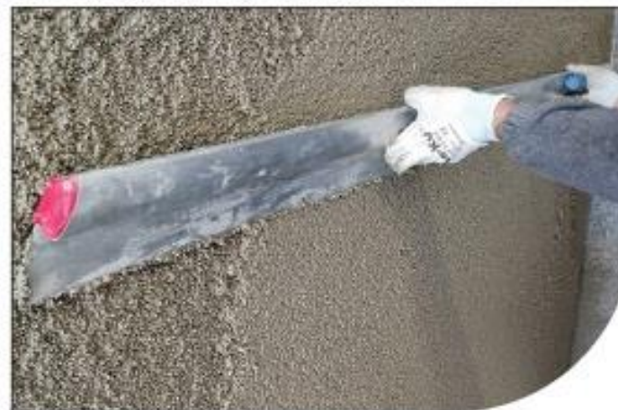
شمشه کشی جهت اجرای سطح صاف
