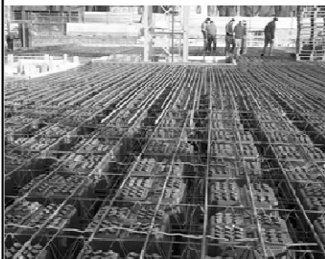
دال مجوف قبل از بتن ریزی
